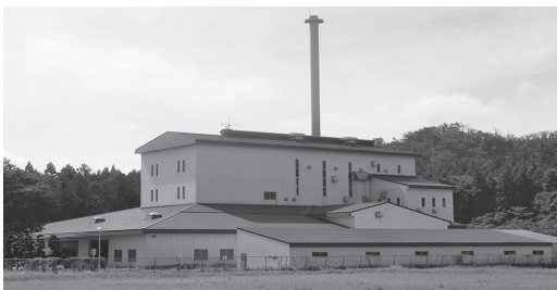
西部玉造クリーンセンター（大崎市岩出山）
