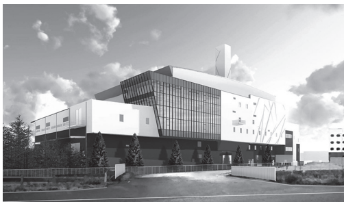
西地区熱回収施設（ごみ焼却施設）（大崎市古川）
