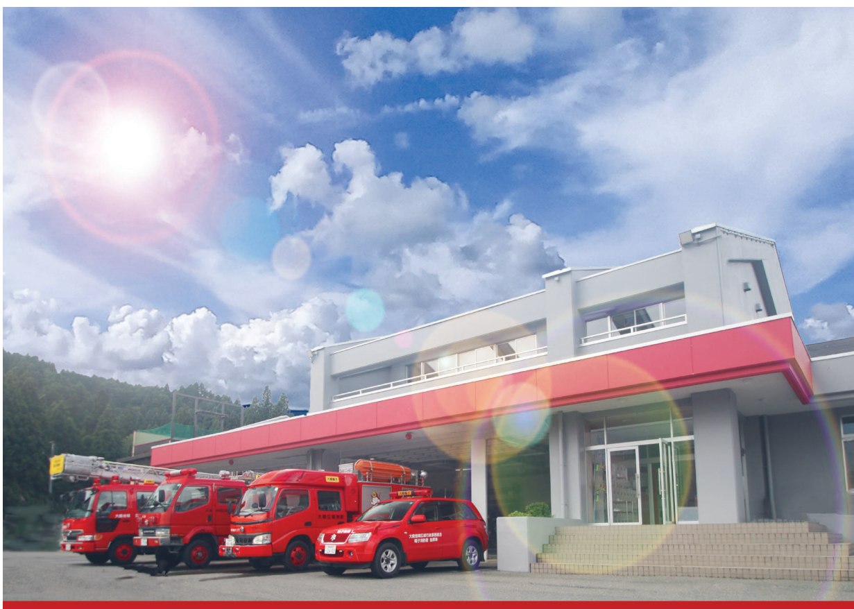
「鳴子消防署」 令和 7 年度庁舎改修工事完了
